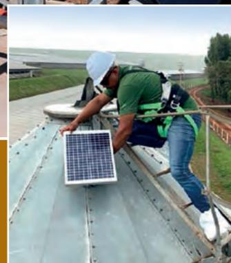
**TECNOLOGIA.** Sensores instalados nos silos fazem uma leitura 3D do volume de ração existente. Os sensores são movidos a energia solar e precisam somente de sinal de internet ou de telefonia para a comunicação com a fábrica da Lar
