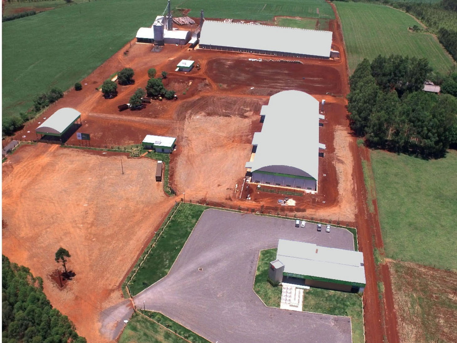
ESTRUTURA. A quarta Unidade Lar em Aral Moreira (MS) tem 11.000 metros quadrados de área construída
