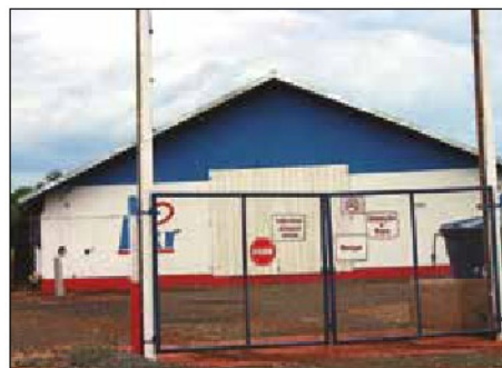
INVESTIMENTO. R$ 300 mil foram aplicados na construção do aviário
